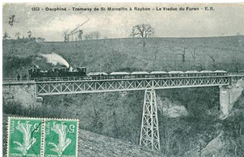
Photo du viaduc du Furan (13)
