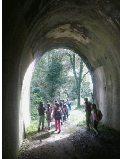
Photo du tunnel de Dionay (12)
